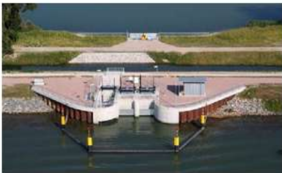
Figure 8 : Polder de Söllingen 18 : ouvrage de prise au droit du PK 318
