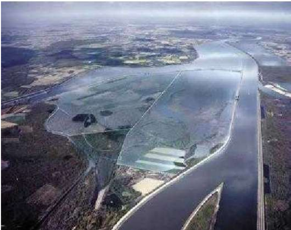
Figure 19 : Vue générale sur le site du polder d'Erstein 33
