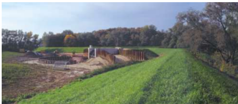
Figure 12 : Construction de l'ouvrage de sortie du polder 21
